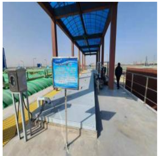
废水处理设施 6：MBR 膜区
