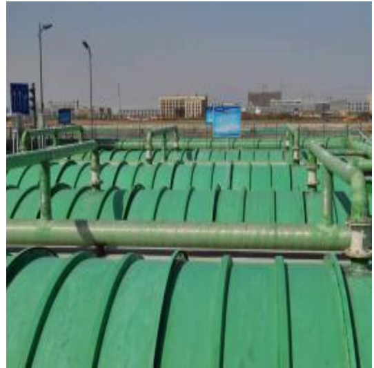
废水处理设施 2：水解酸化池
