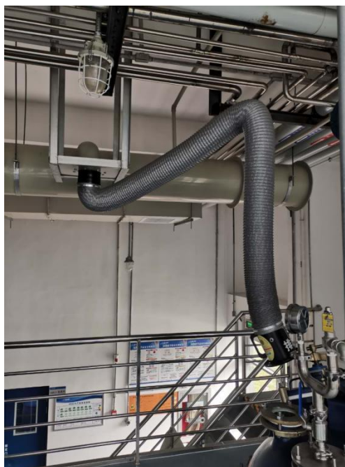
图7.1.2-3 兼顾定位与固定作用的移动式集气罩示意图
