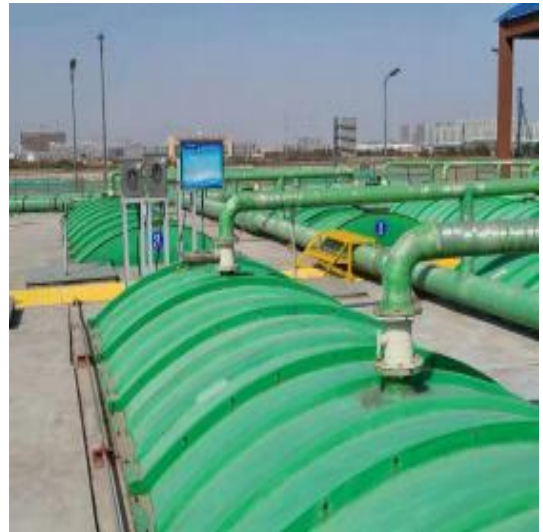
废水处理设施 2：水解酸化池
