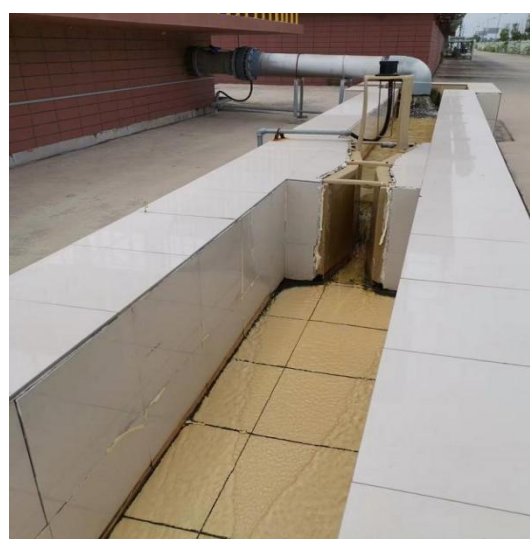
废水监测井及排口
